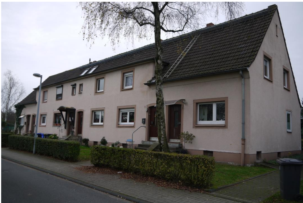
Abbildung 13 Haustyp D mit sechs Wohneinheiten, Zwerchhaus auch über den mittleren Eingängen
