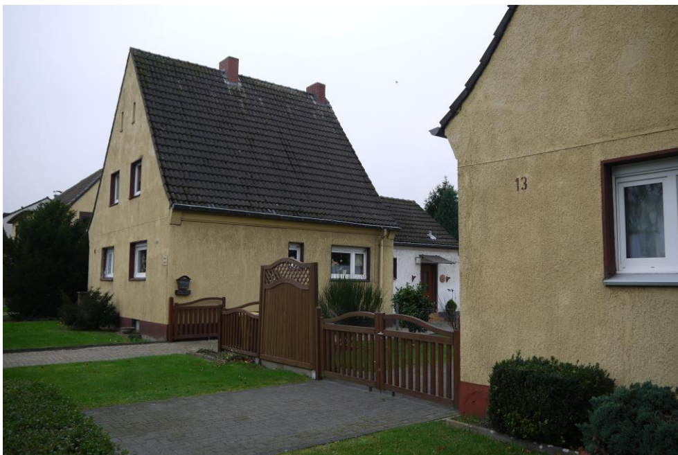
Abbildung 22 Grundstückseinfassung zwischen den giebelständigen Haustypen 21A. Schön ist hier die nachbarschaftliche Einigung auf ein gestalterisches Element. Das mittlere geschlossene hohe Element des Zauns ist nach den vorangegangenen Gestaltungskriterien bei einer Neugestaltung nicht mehr zulässig.
